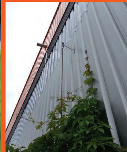
Markbäddar för klättrväxter och ett vajer/spaljé-system är en säker, prisvärd och effektiv metod för att skapa gröna fasader
